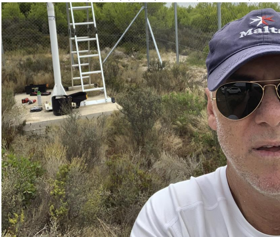
Εικόνα 1.2-13: Απο τις τεχνικές εργασίες στον σταθμό ZKT-1 στις 21/7/2023.
