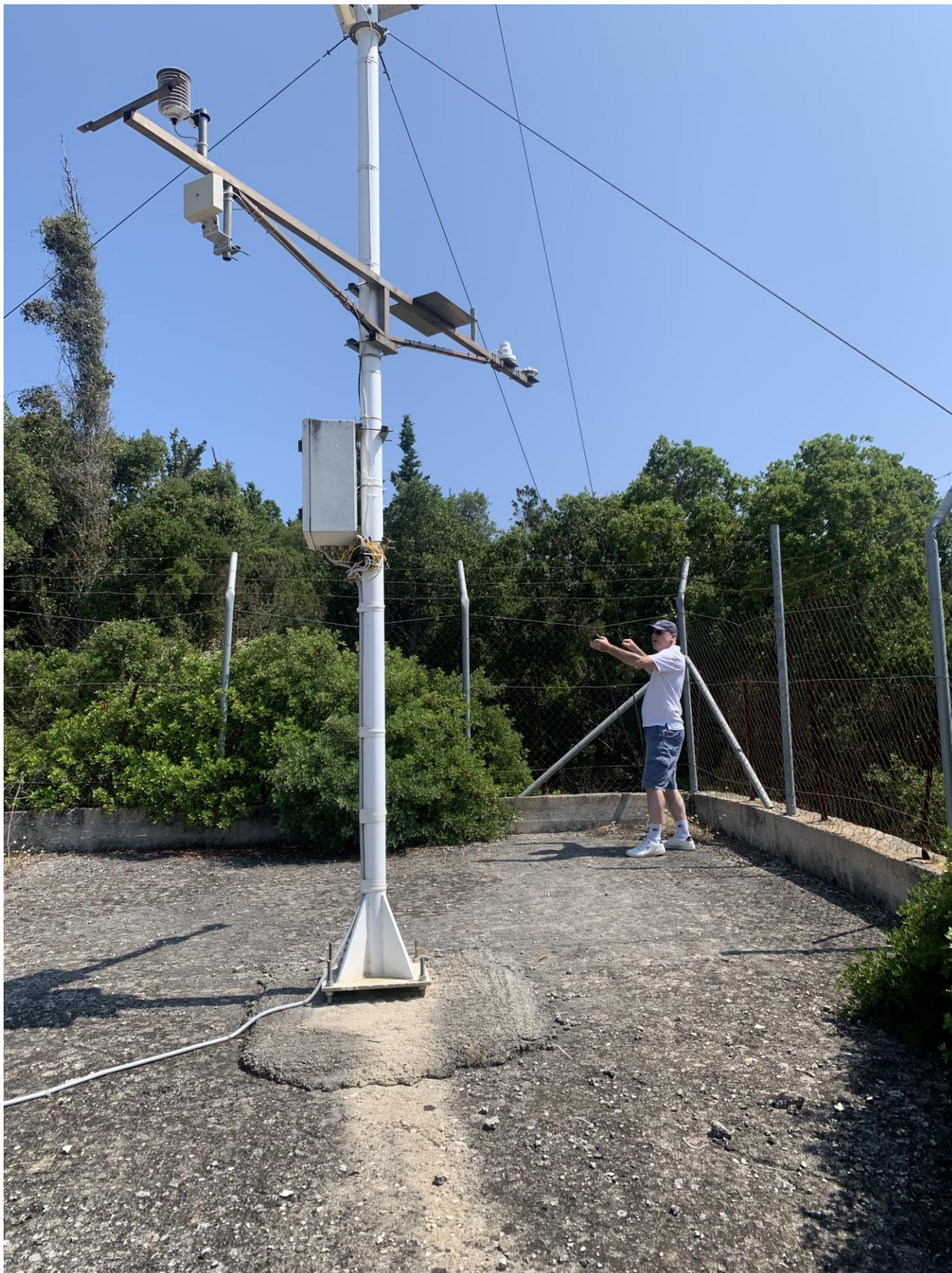
Εικόνα 1.2-9: Απο τις τεχνικές εργασίες στον σταθμό ΚΕΦ-1 στις 6/7/2023
