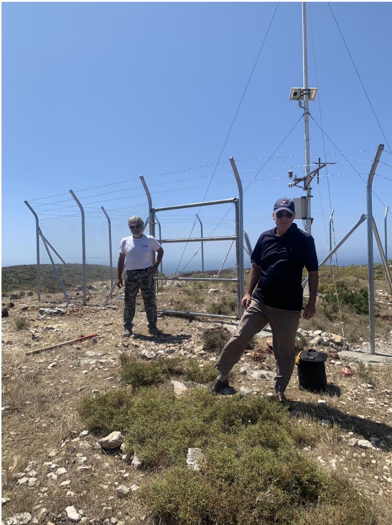
Εικόνα 1.2-10: Απο τις τεχνικές εργασίες στον σταθμό ΚΕΦ-2 στις 7/7/2023
