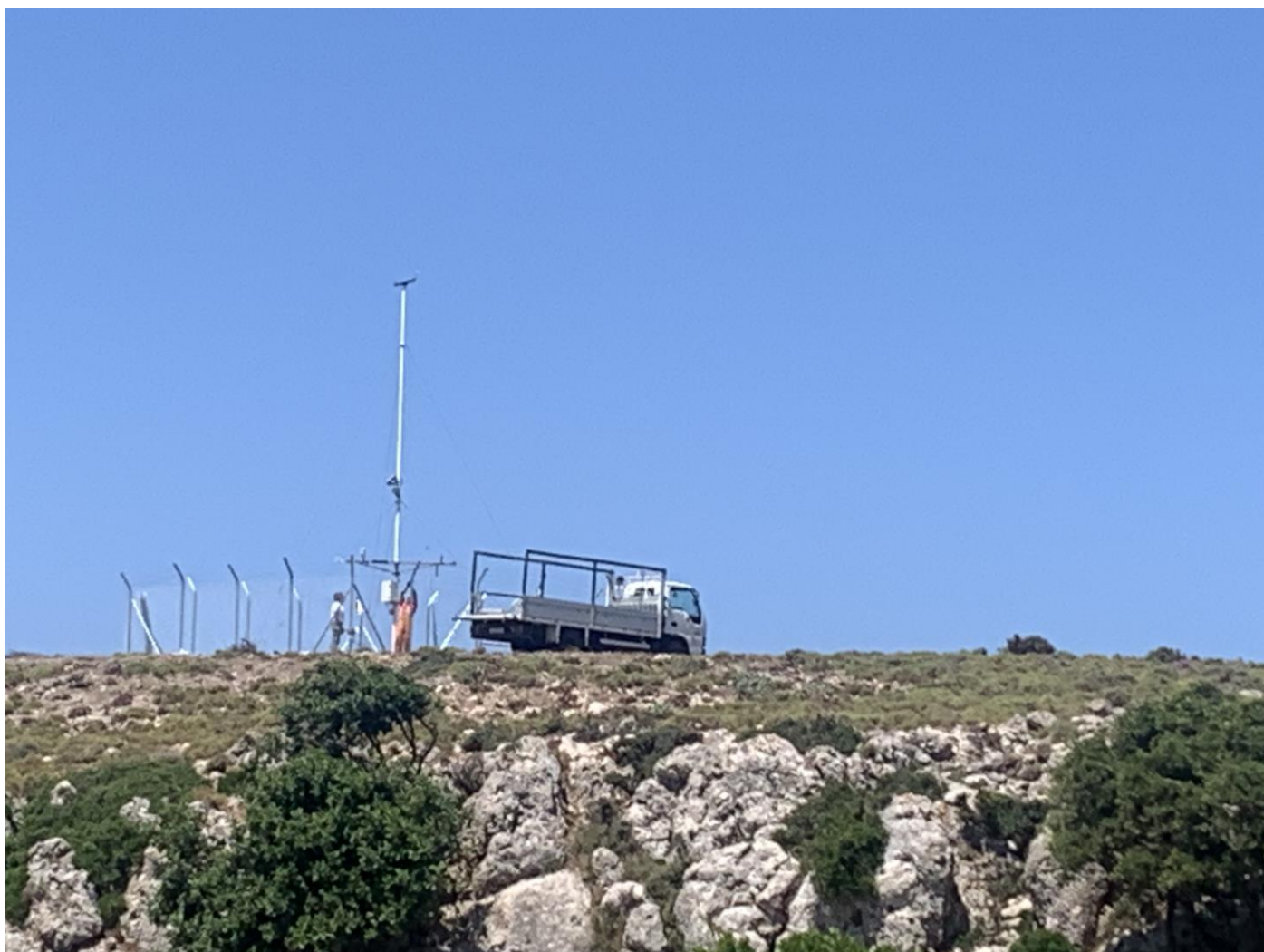
Εικόνα 1.2-5: Απο τις τεχνικές εργασίες στον σταθμό ΚΕΦ-2 στις 6/7/2023.
