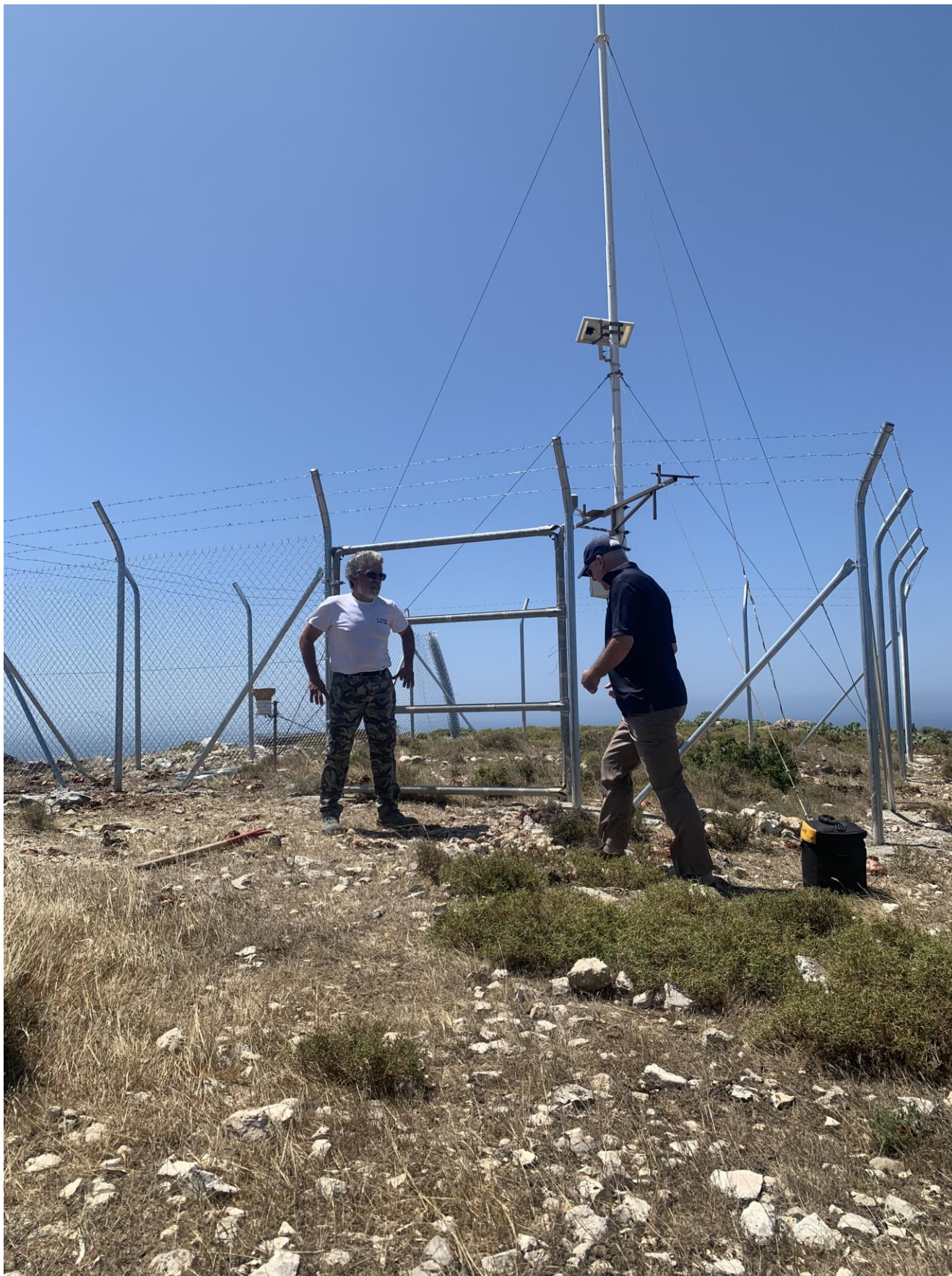
Εικόνα 1.2-11: Απο τις τεχνικές εργασίες στον σταθμό ΚΕΦ-2 στις 7/7/2023
