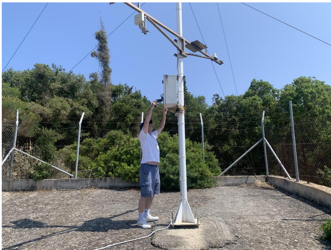
Εικόνα 1.2-8: Απο τις τεχνικές εργασίες στον σταθμό ΚΕΦ-1 στις 6/7/2023
